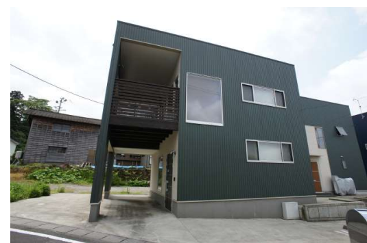
建物② (A棟)
