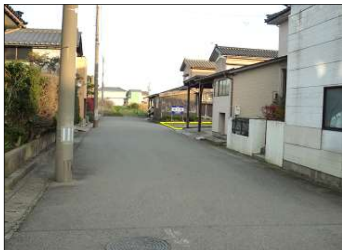
前面道路の様子
